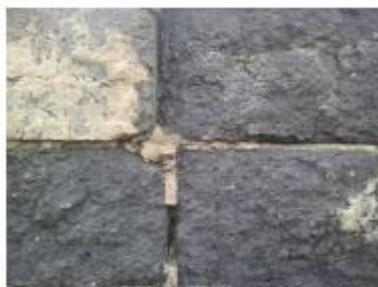
*Blocs agglomérés de béton de mâchefer*
